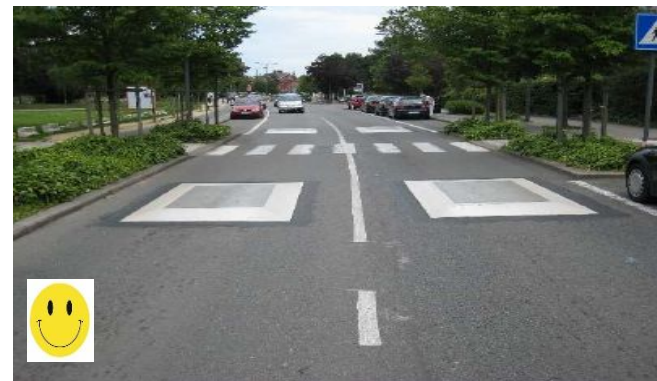
Figure 7 : Installation de coussins côte-à-côte à proximité d'un passage piéton sur une chaussée dont la largeur est comprise entre 6 m et 7,2 m [CRR 2020_1]
