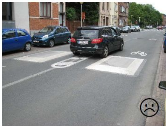
Figure 5 : Implantation de deux coussins côte à côte sur une chaussée dont la largeur est comprise entre 6 m et 7,2 m (coussins séparés par une ligne blanche continue \geq 10 m) [CRR 2020_1]
